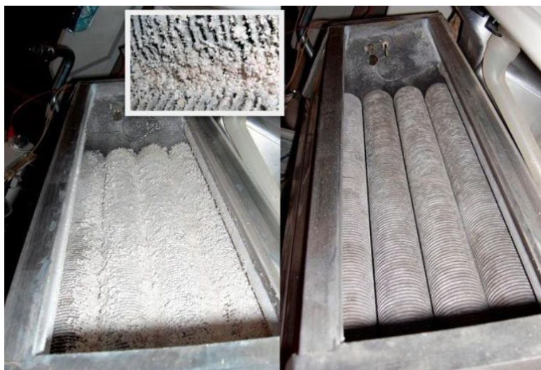
1. attēls Nenotīrīta apkures katla detaļa [3]
